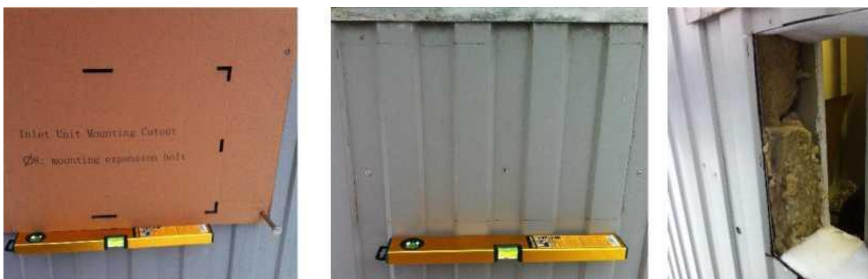
Рис. 9 Вырезка отверстия для приточного блока
