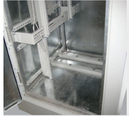
Место для установки АВР и трансформатора
