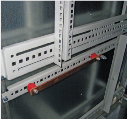
Шина заземления
