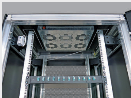
Встроенный блок вентиляторов с термостатом
